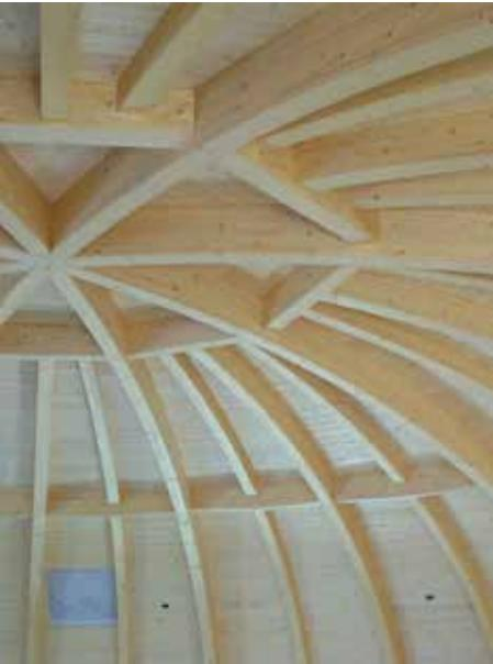
L'**aspetto semisferico delle strutture**, oltre a rendere riconoscibile ed identificabile la costruzione nel suo complesso, **aiuta a limitare le dispersioni termiche**, permettendo di contenere il massimo volume a parità di superficie disperdente.
